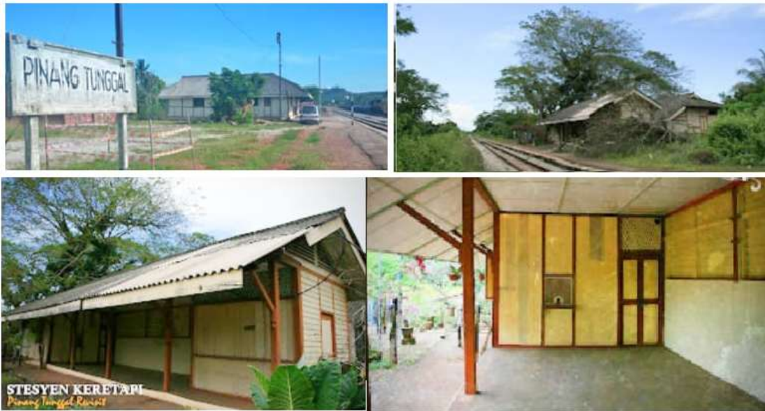
GAMBAR 98 : Stesyen Keretapi Pinang Tunggal dibina pada 1915 dirobohkan 2020
